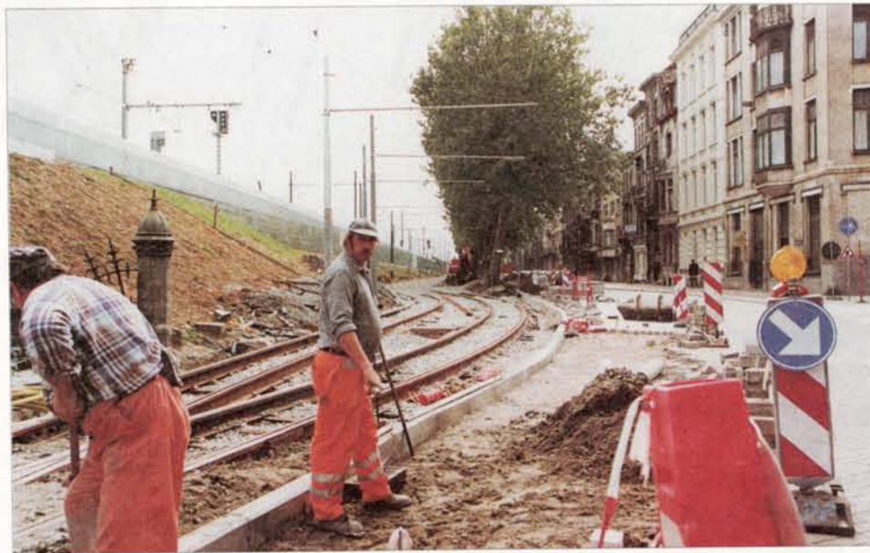
☒ Werken aan de tramlijn van de Cuperusstraat. Omdat de brug van de Arendstraat dicht gaat voor auto's en trams, moet de lijn worden verlengd tot de Lange Leemstraat.
